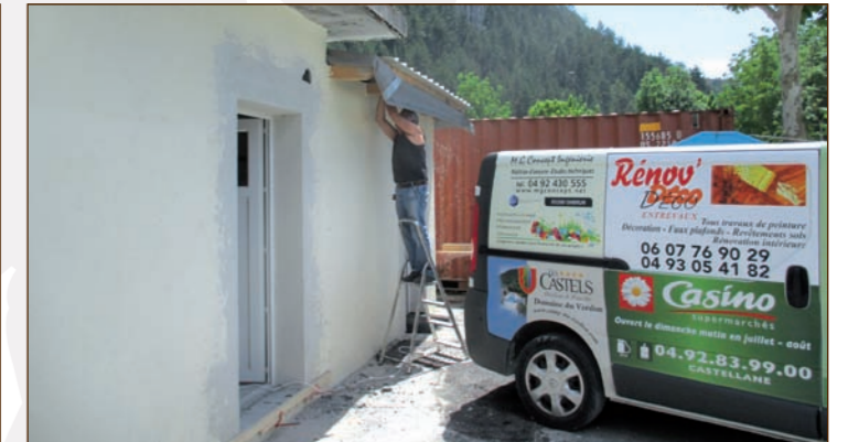
Réalisation WC publics salle des fêtes
