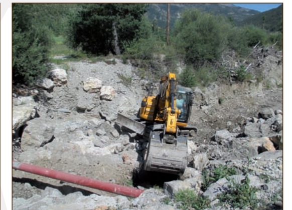
Réparation réseau eaux usées Cheiron
