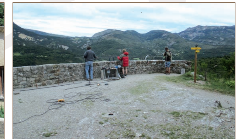
Garde-corps chapelle Notre-Dame du Roc
