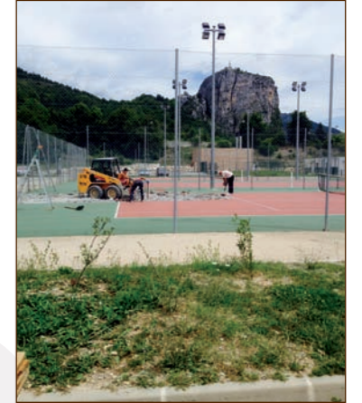
Réfection des tennis
