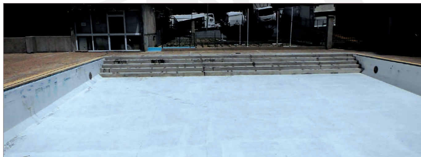
Réparation des escaliers petit bassin
