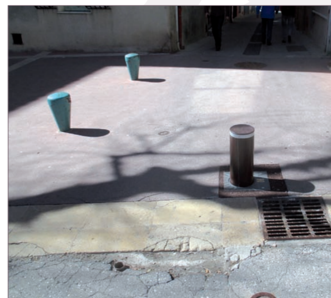
Installation de bornes rue piétonne
