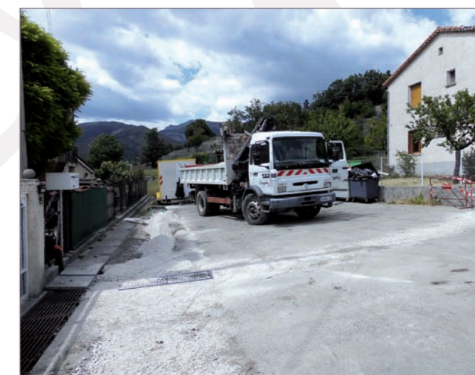
Enfouissement des réseaux à la Cèbière entreprise CEGELEC
