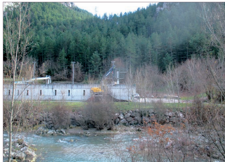
Démolition plongeur entreprise EIFPAGE
