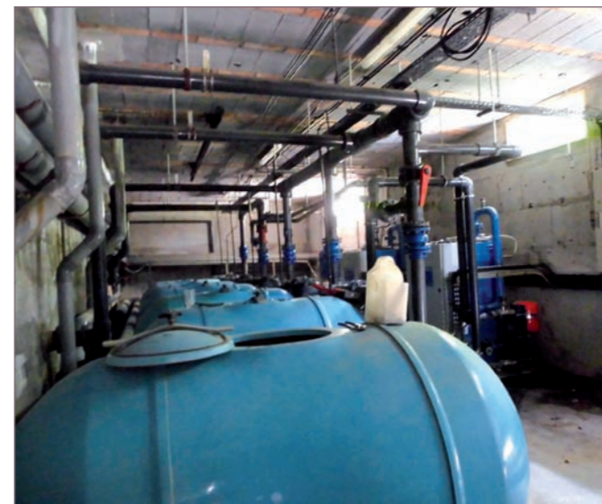
Réparation pompe chaleur piscine
