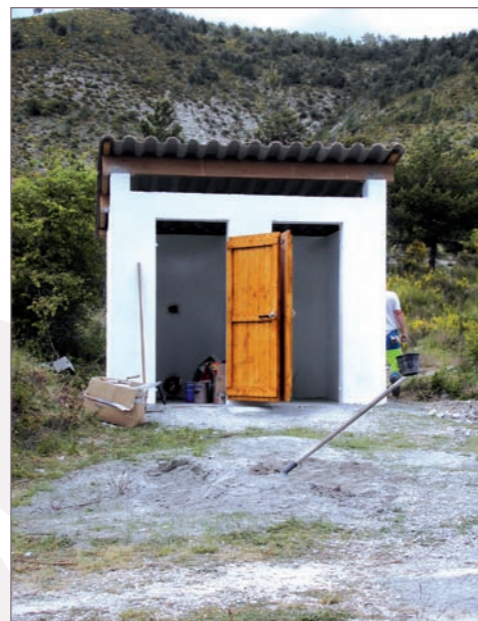
Création de WC au Cheiron
