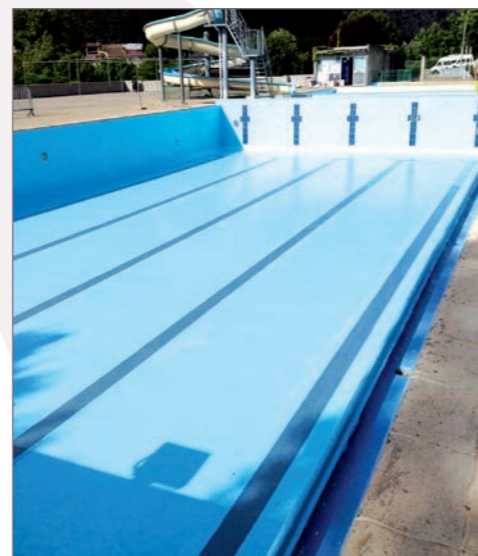
Peinture des bassins piscine
