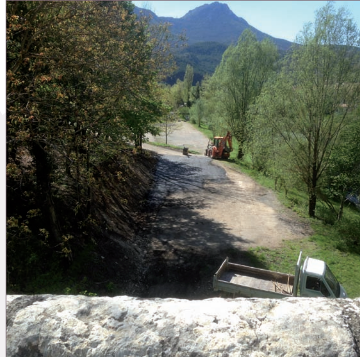
Aménagement en face de la Boudousque
