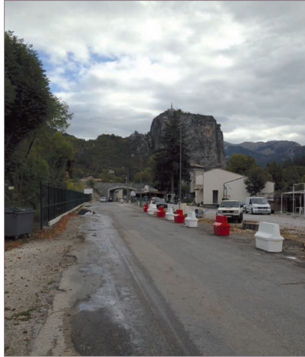
Installation tuyaux à l'entrée de Castellane
