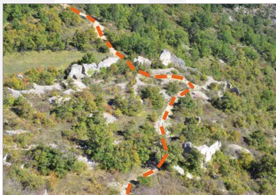
Réalisation tranchée pour amener l'eau à la chapelle ND du Roc
