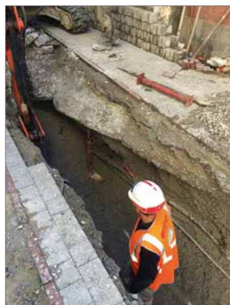
Curage du réseau pluvial de la rue Saint Victor
