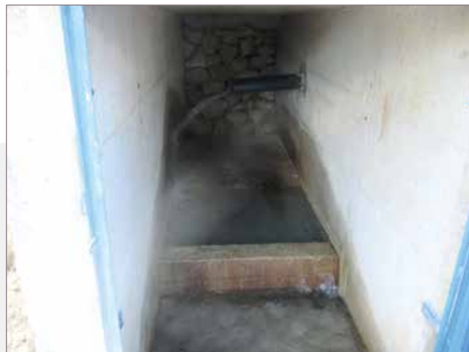
Amélioration du captage de la source de Brayal
