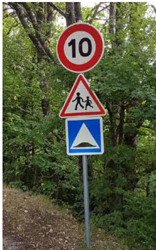
Pose de la signalisation 10 km/h - hameau de Chasteuil
