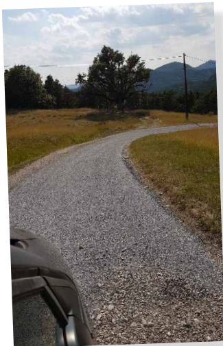
Réfection de la piste qui mène à la station d'épuration - hameau d'Éoulx
