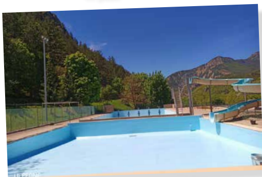
Réhabilitation de la piscine
