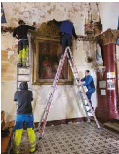
Dépose du mobilier protégé de la chapelle Notre-Dame du Roc
