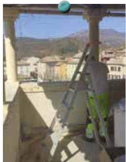
Pose d'un filet à pigeons
