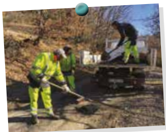
Intervention de voirie
