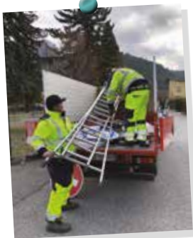
Mise en place d'une nouvelle signalisation Quartier Notre-Dame
