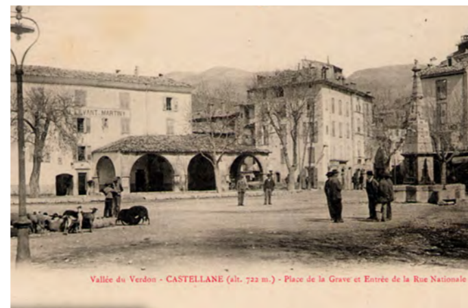
La halle qui accueillait le marché au XIXe siècle illustrant le déplacement du centre de gravité du village vers la place de la Grave
