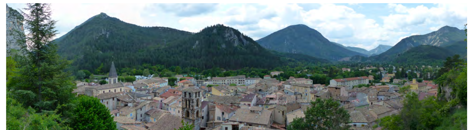
Les remarquables échappées visuelles offertes sur la ville depuis les jardins de la Tour
