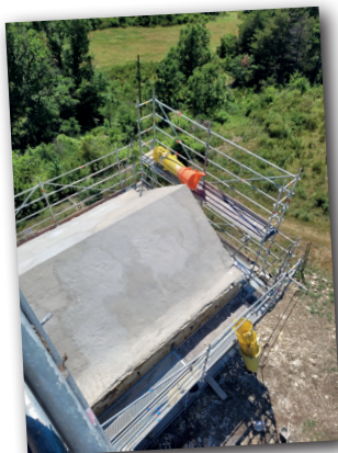
Réfection de la toiture de la nef en lauze
