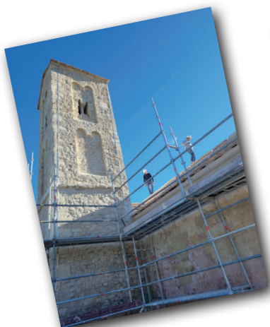
Restoration de la façade sud et reprise de l'enduit à pierre vue.
