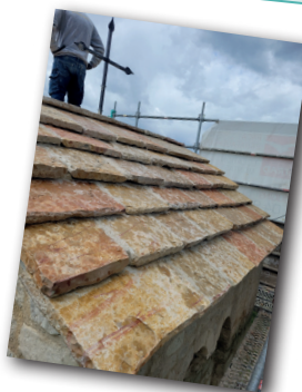
Mise en œuvre de la toiture du clocher en lauze
